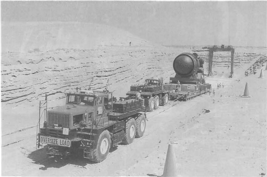
写真3 原子炉圧力容器パッケージの積み降ろし準備
