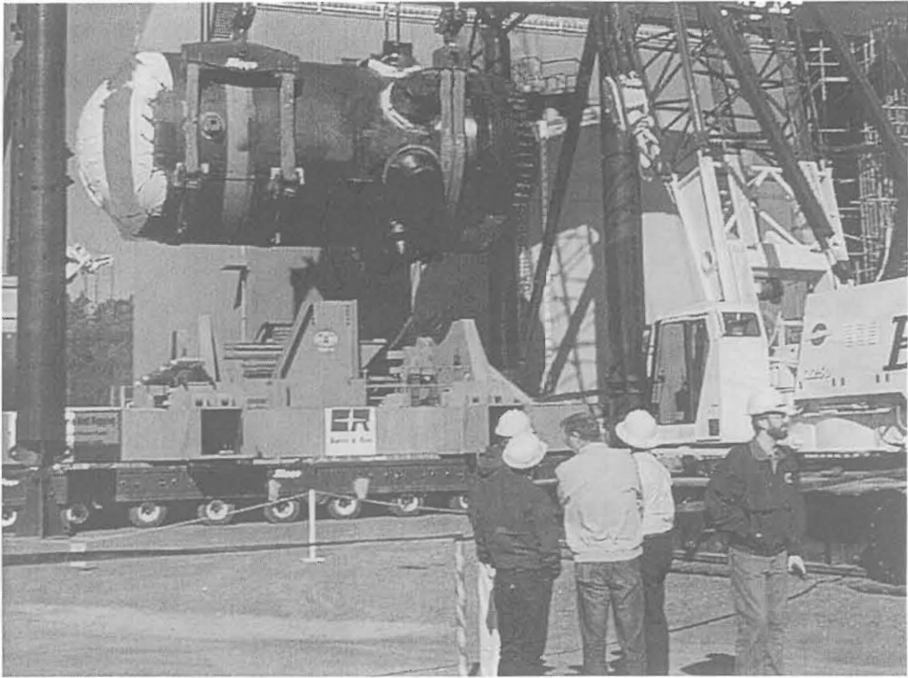
写真1 原子炉圧力容器パッケージのトレーラへの吊り込み
